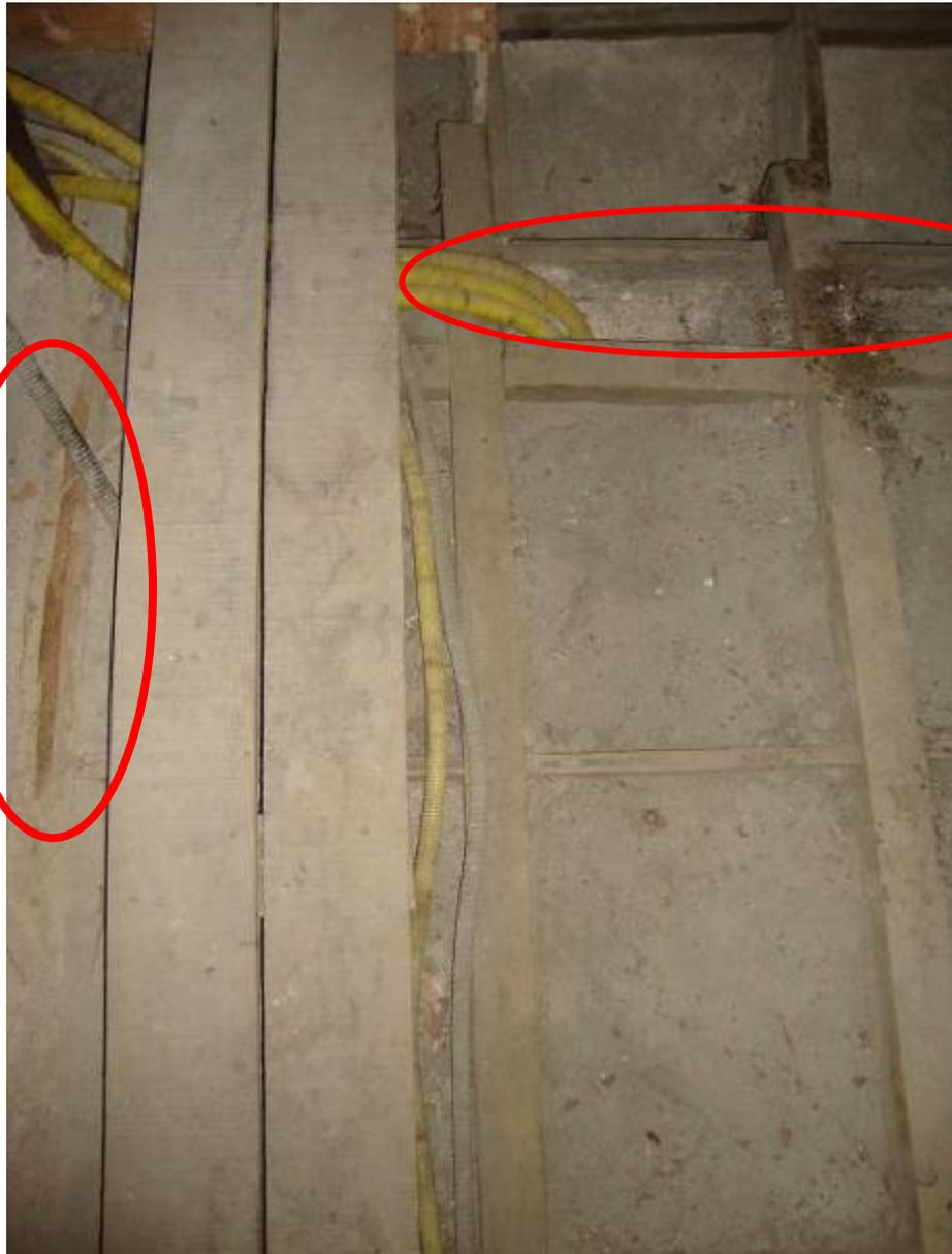
**Figura 3 - Áreas em destaque por linha vermelha: resquícios de fezes de morcego e passarela de acesso no interior do telhado sobre o forro da sala 2. Fotografia: Ivo Almico, 03/05/2013.**
