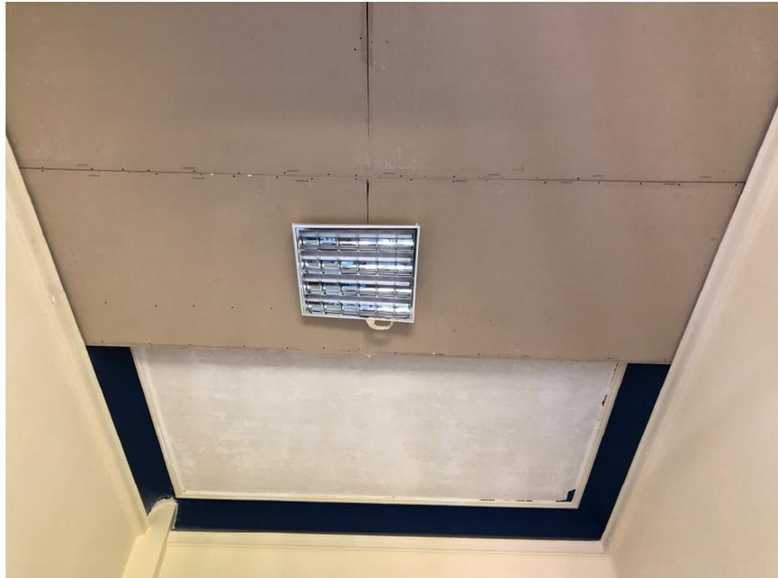
**Figura 13 - Área da entrada com forro provisório da sala 2 - onde se vê o teto original, e parte do forro provisório que foi instalado substituindo o trecho do teto que estava com desprendimento, sendo retirado e substituído por dry-wall (provisório).**
