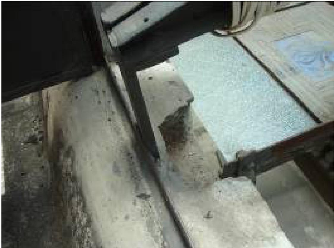
**Figura 29 - Lacuna da alvenaria no ponto de fixação da estrutura metálica.
