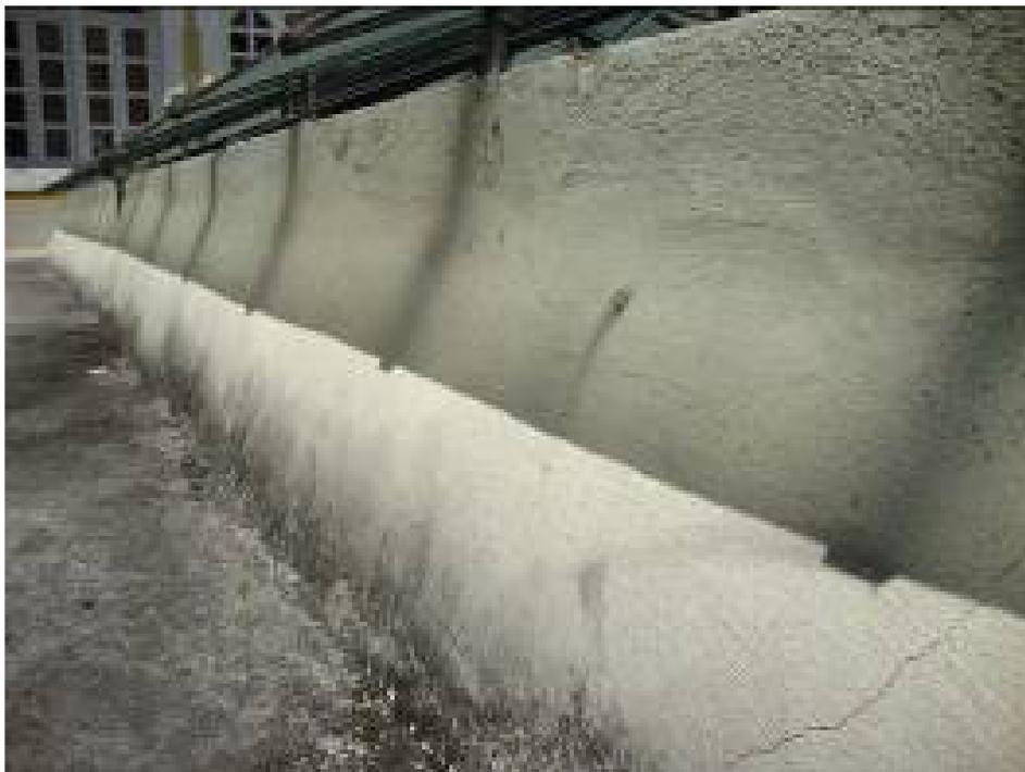
**Figura 19 - Base de alvenaria para o apoio da estrutura.
