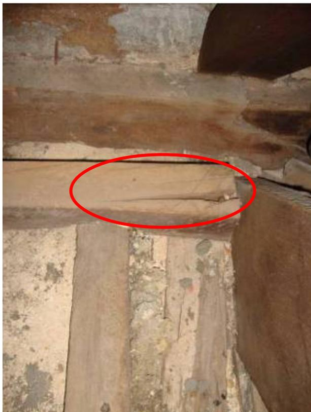
**Figura 12 - Trinca aparente em peça de madeira da estrutura.
