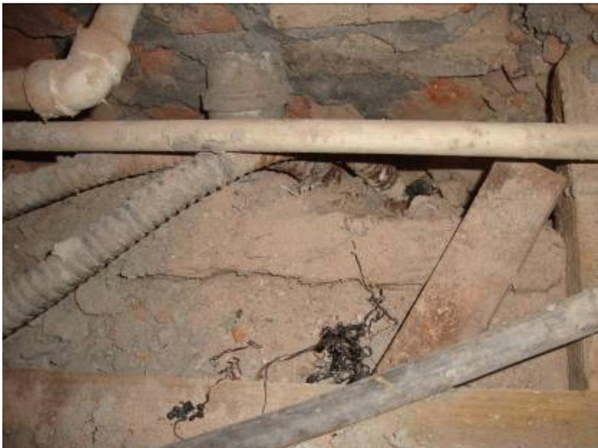
**Figura 8 - Detalhe mostrando área deteriorada por insetos xilófagos, além de instalações elétricas e hidráulicas antigas. Fotografia: Ivo Almico, 03/05/2013.**
