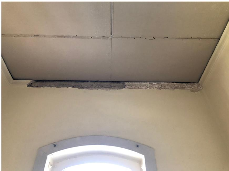
**Figura 14 - Área coberta com Dry-wall provisório - vemos lacuna na sanca por desprendimento de material original, possivelmente ocasionado por umidade descendente originada anteriormente às obras de restauração da cobertura do edifício sede do MAST. Fotografia: Ivo Almico, 14/08/2018.**
