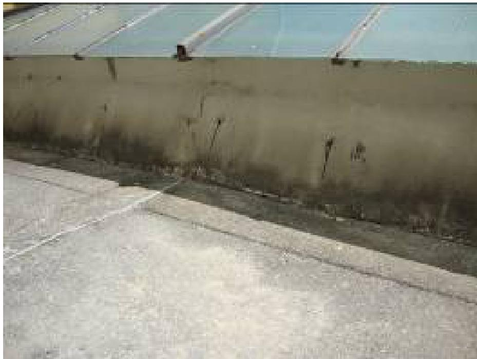
**Figura 25 - Fissura entre a gola de alvenaria e a laje do terraço de cobertura do edifício.
