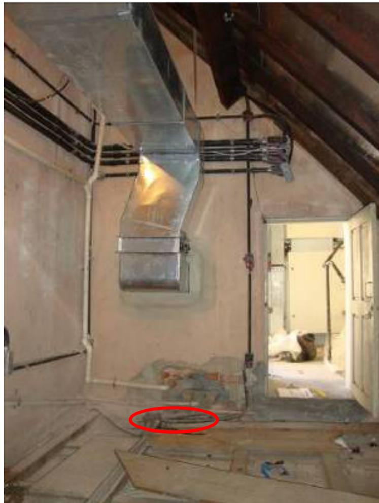
**Figura 7 - Vista do interior do desvão sobre a sala 3 - em destaque a área deteriorada por insetos xilófagos. A porta de acesso tem passagem pela escada para a visita de manutenção. Fotografia: Ivo Almico, 03/05/2013.**
