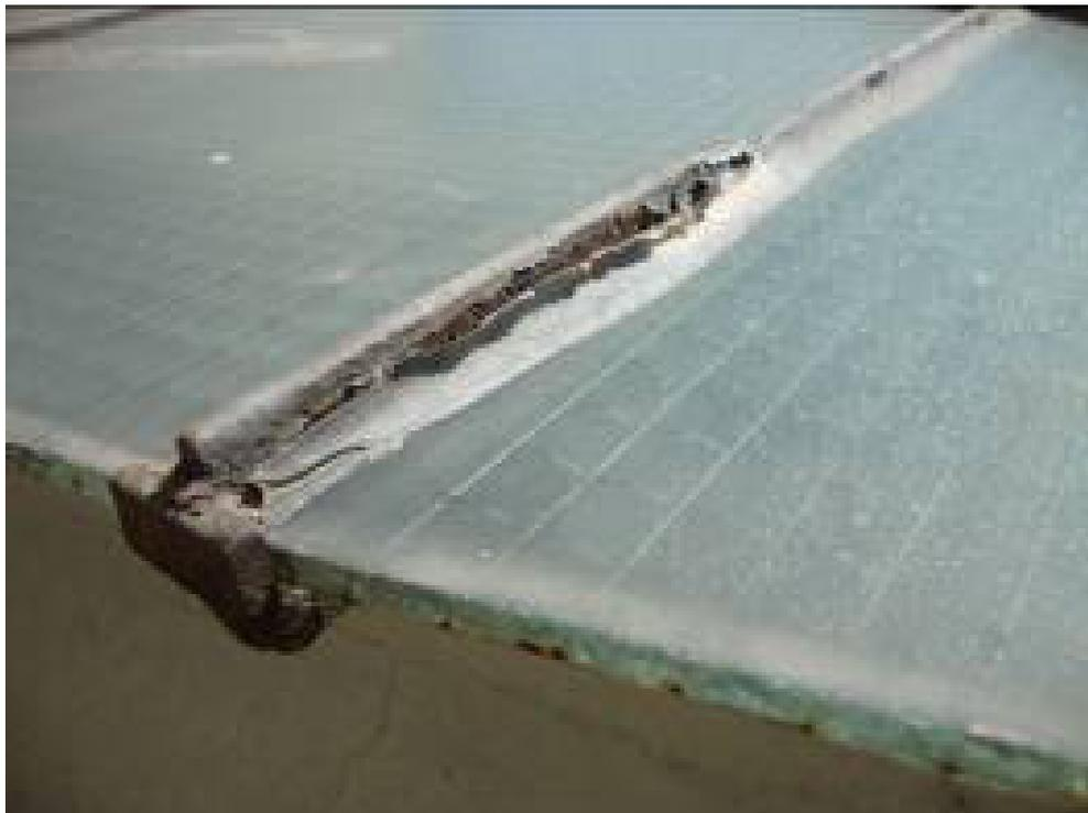
**Figura 23 - Detalhe do encontro do perfil metálico e a folha de vidro aramado com desprendimento do material. Fotografia: Arquivo do SEPTC/COMUS.**
