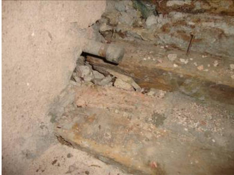
**Figura 10 - Argamassa e partes da madeira de estrutura deterioradas e tubulação antiga aparente. Fotografia: Ivo Almico, 13/06/2013.**
