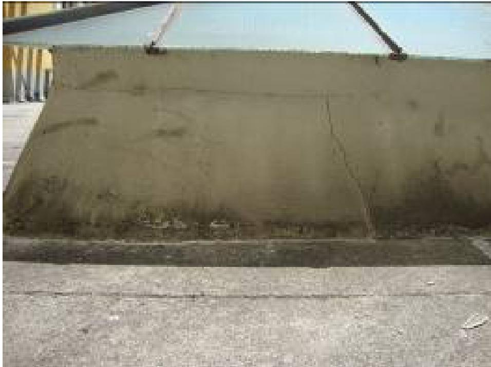
**Figura 28 - Fissuras na argamassa. Fotografia: Arquivo do SEPTC/COMUS.**
