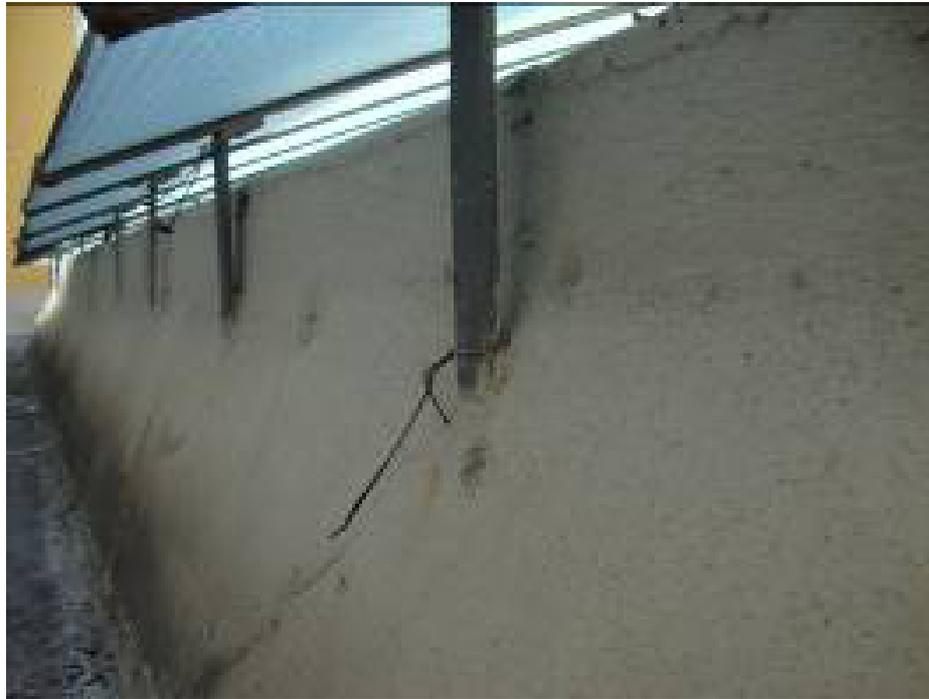
**Figura 24 - Detalhe da fixação da chapa metálica na gola de alvenaria.
