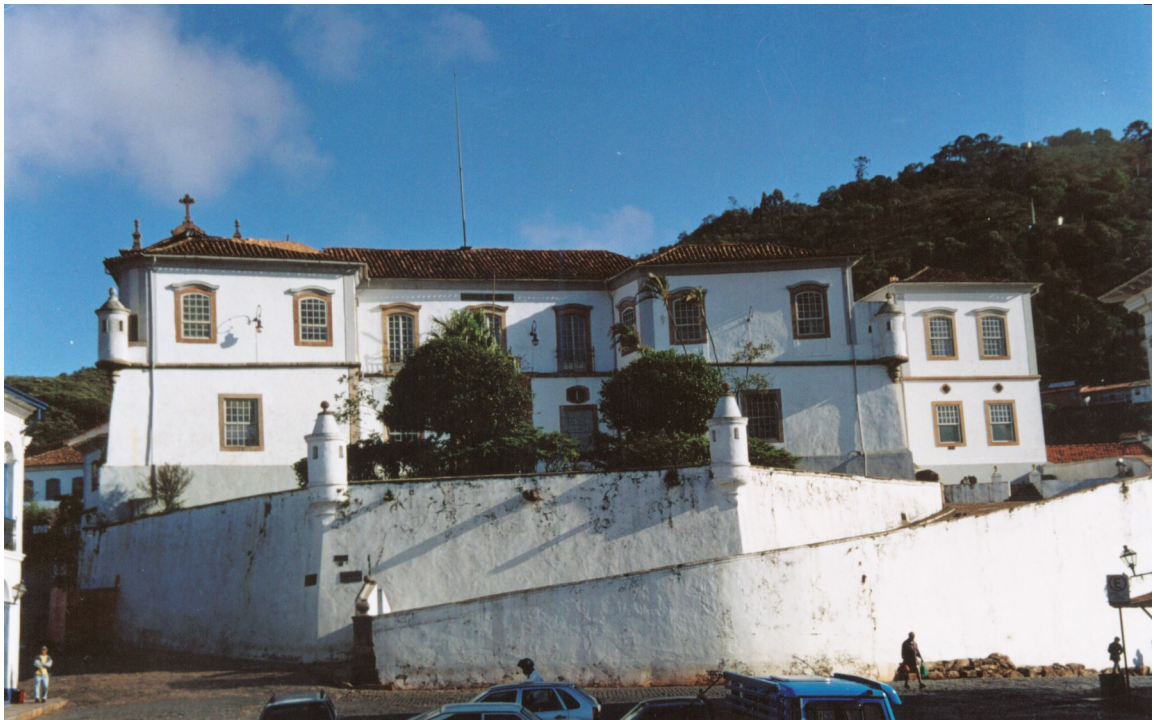
Figura 1 - Fachada do prédio do Museu de Ciência e Técnica da Escola de Minas da UFOP (Acervo UFOP; fotografia Antonio Laia).
