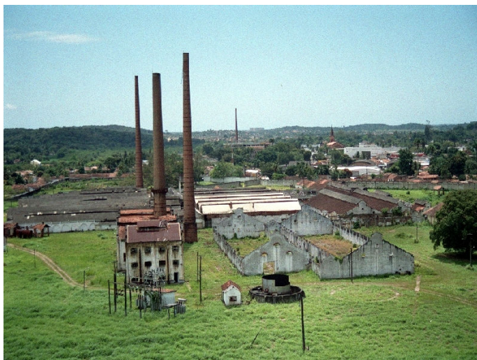
Foto 5 - Ruínas da fábrica Aurora (fim dos anos 2000) que na foto de cima (que se vê de baixo pra cima, de perto pra longe) aparece no seu topo superior (ponto de vista mais ao chão do panorama da ponta invertida da foto superior).
